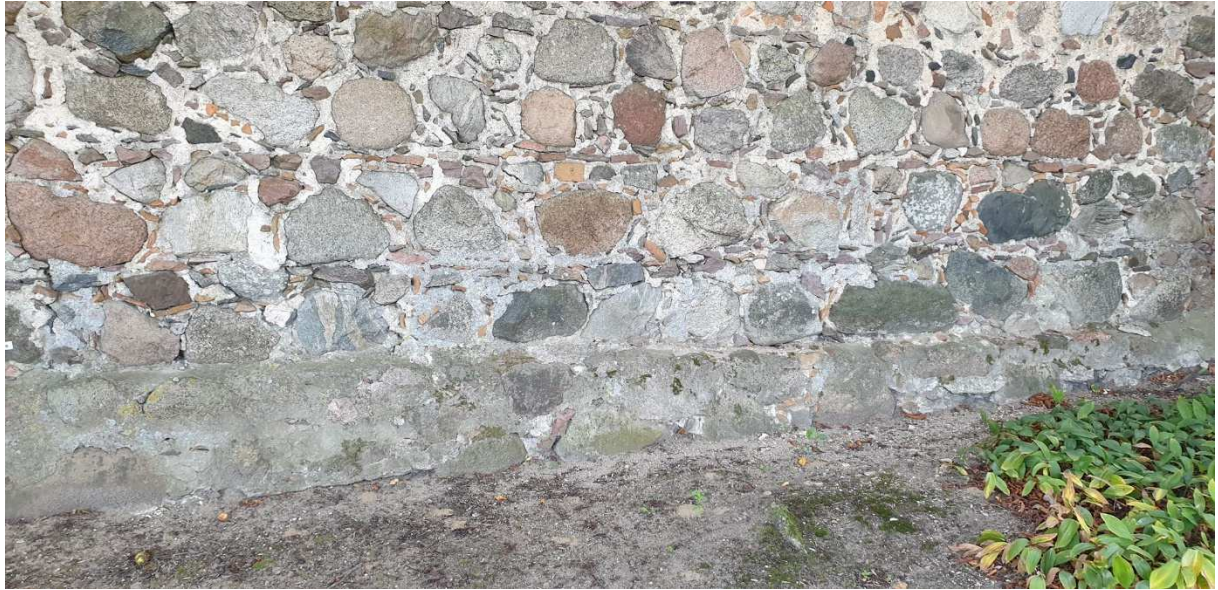
Fot.5. Kruszyny, kościół pw. św. Mikołaja. Widok ogólny na wątek kamienny (elewacja południowa). W wątku kamiennym widoczna jest lokalnie jasna zaprawa historyczna oraz liczne odłamki ceramiki.
